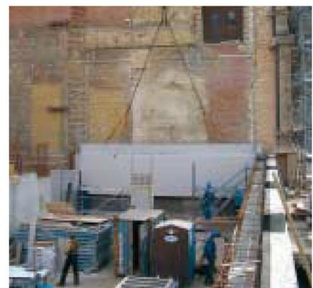
Abb. 11: Montage einer freitragenden, 21 t schweren Wandscheibe
