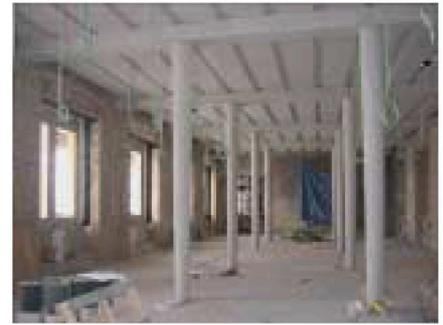
Abb. 6: Karottenstützen
