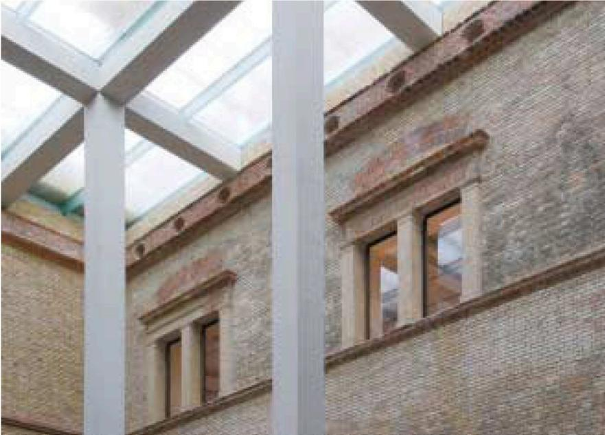
Abb. 12: Ägyptischer Hof, Stützen Balkenrost – Glasdachebene
